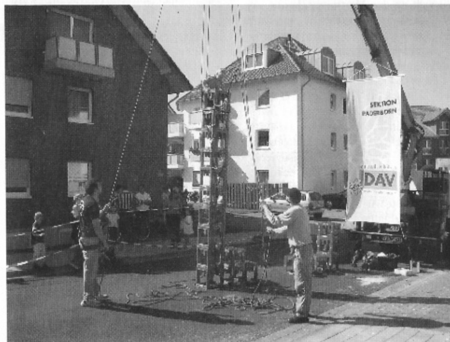
Bild: Auf dem Weg nach ganz oben mit Hilfe des DAV, Sektion Paderborn
