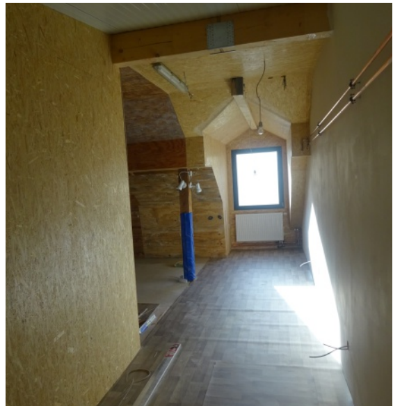
Der alte Dachboden wurde mit einer Gaube erweitert.
