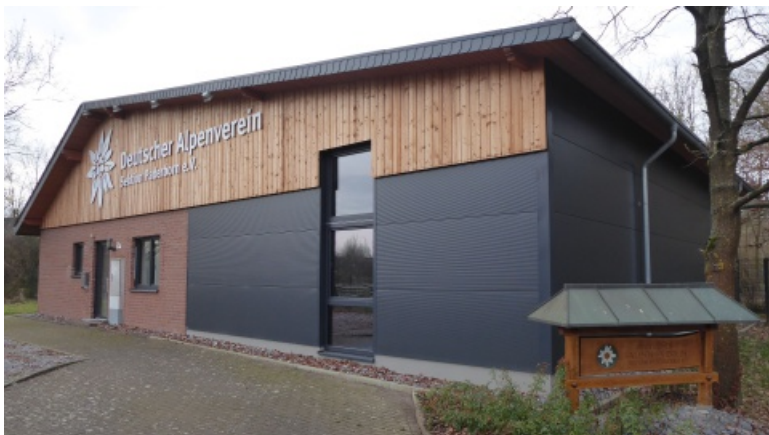
Das Sektionshaus nach dem Umbau mit neuer Beschriftung am Eingangs-Giebel
