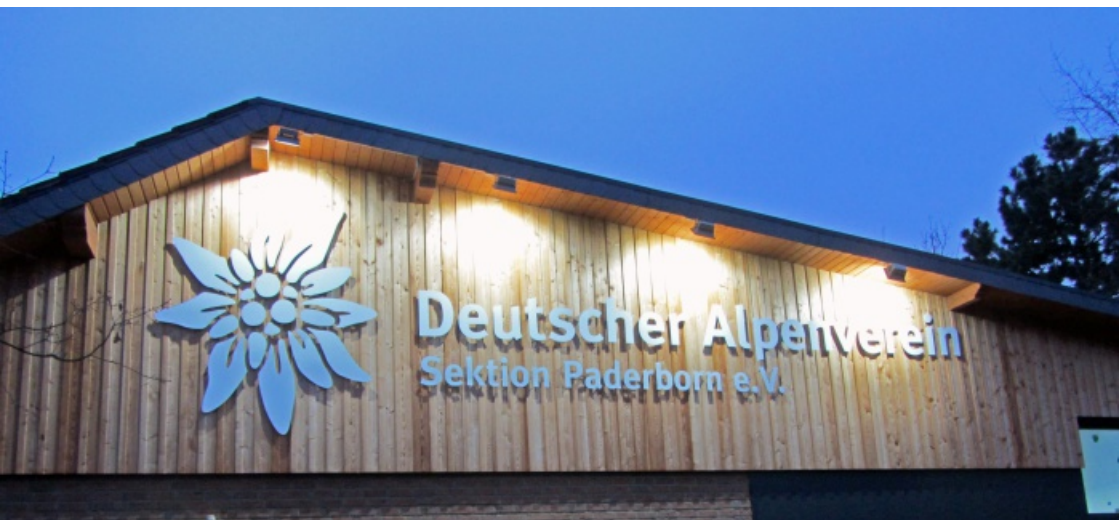
Neuer beleuchteter Schriftzug am renovierten Sektionshaus
