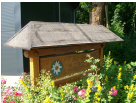
Eine provisorische Abdeckung des Daches mit Teerpappe.
