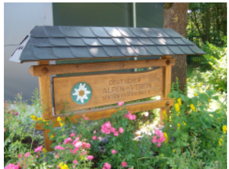
Das fertig restaurierte Dach, mit Eternit-Dachplatten bedeckt.
